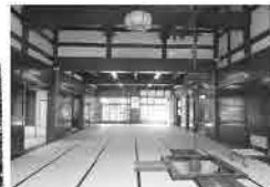
板間を畳敷きに改修した御上の間
